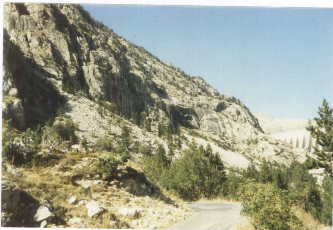
Foto 19 (51/D27).- Hoja 181. Afloramientos graníticos en las proximidades de la presa de Estany Lavallers.
